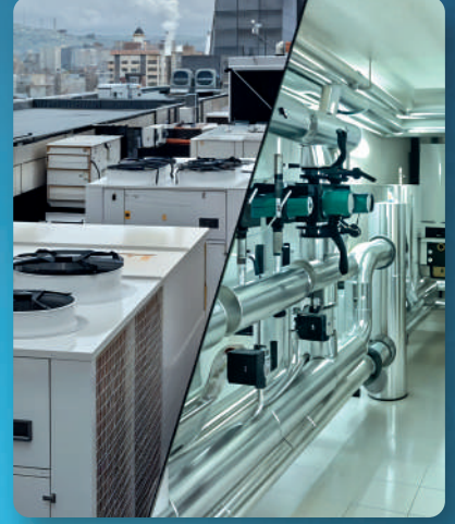
ISITMA-SOĞUTMA TESİSAT UYGULAMA
